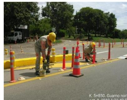
Esta actividad consiste en limpieza, lavado y reposición de hitos plásticos con el fin de mantener en óptimas condiciones de seguridad dicha intersección, garantizando un adecuado servicio tanto en el día como en la noche.
